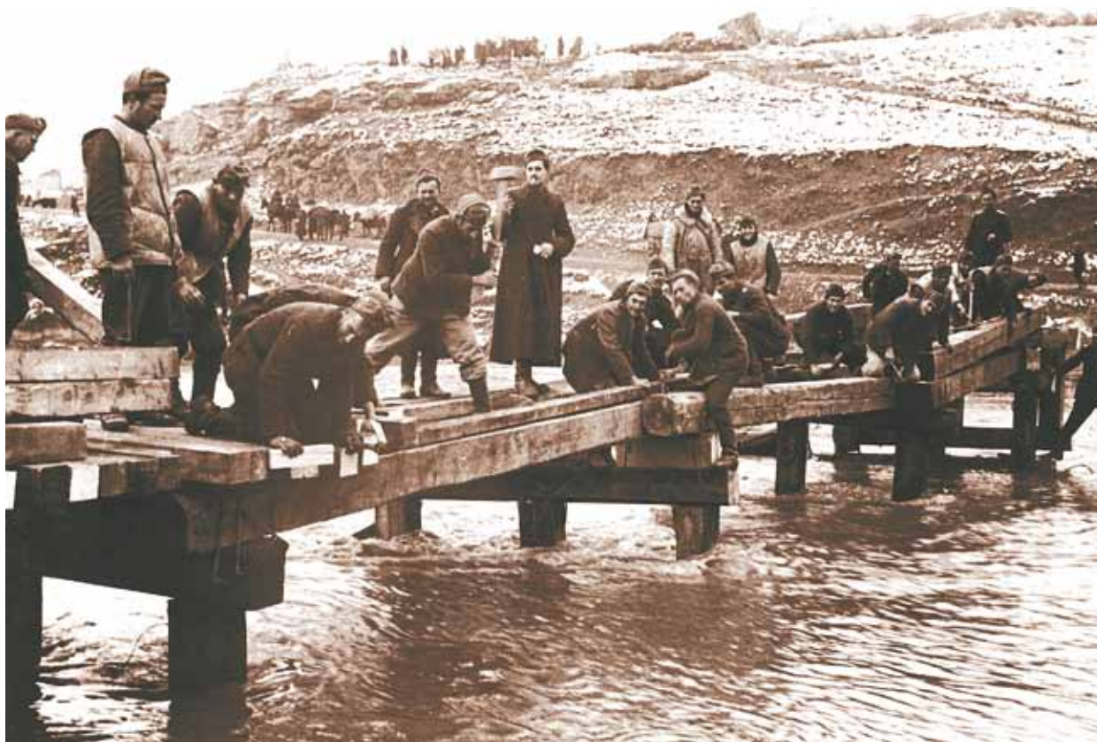
Строеж на мост на р. Пчиня при с. Катаханово
